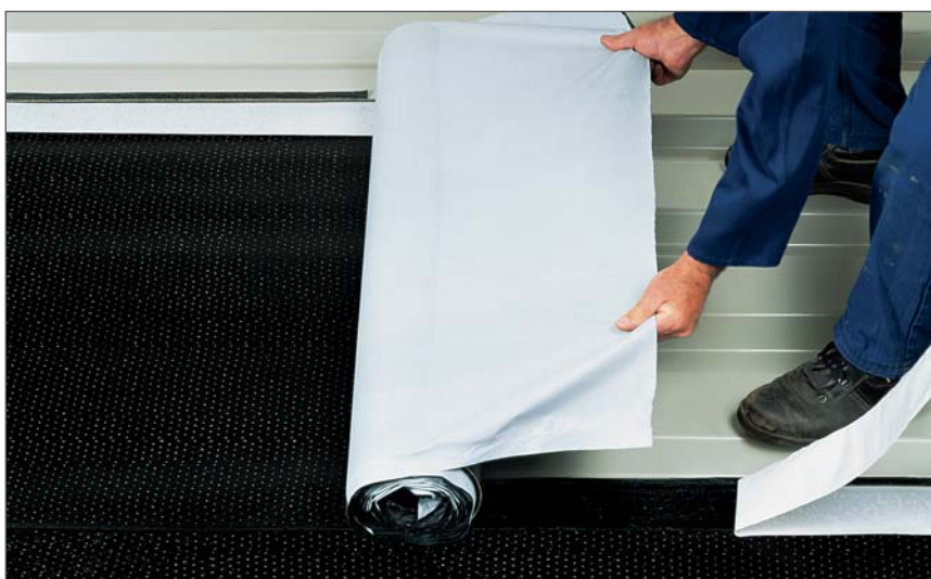
Einfaches Verlegen der kaltselfstklebenden Elastomerbitumen-Dampfsperrbahn
